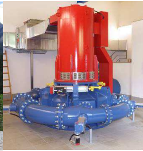
Turbina Pelton/generatore
